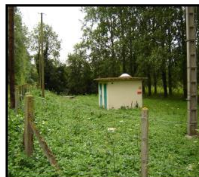
Local de la station de pompage
