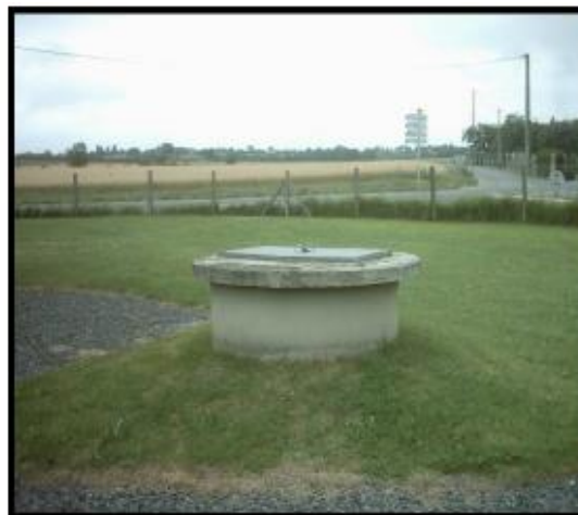
Vue extérieure Forage F1 (Ranville)
