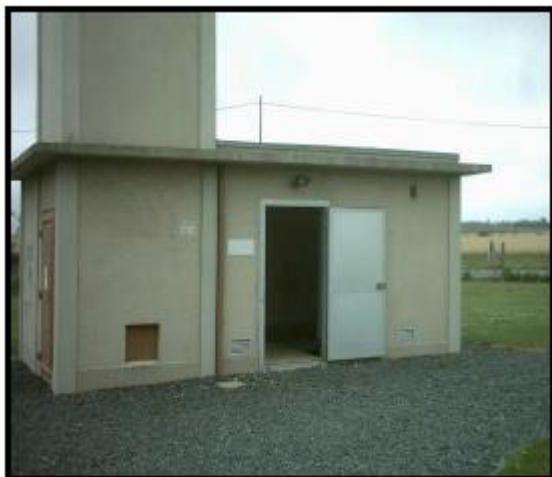
Local de la station de pompage du forage F1
